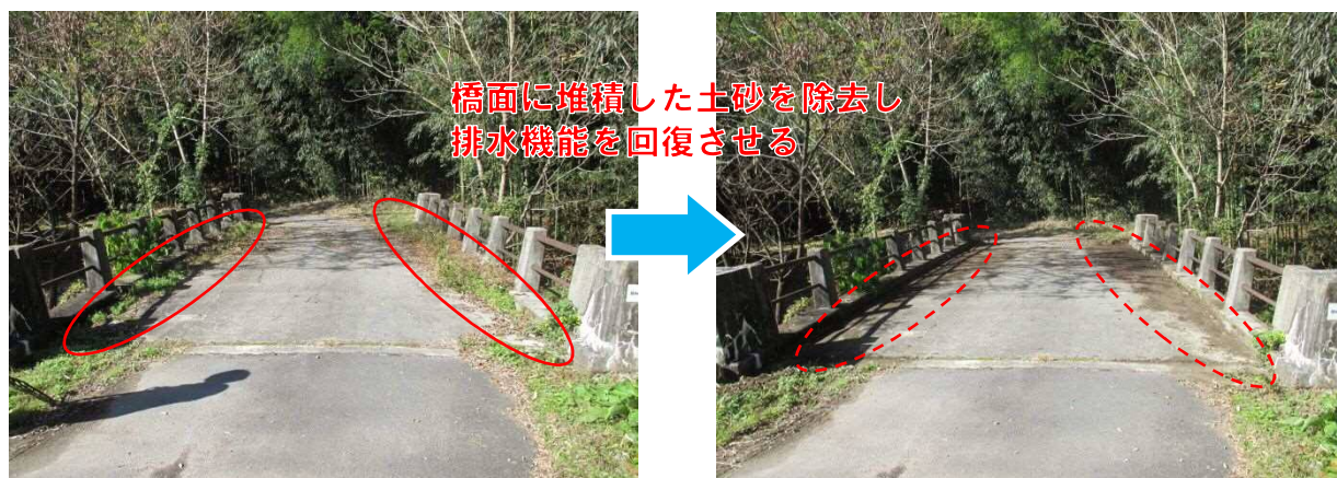
図 3.2 簡易な維持作業の例（土砂の除去）：郷土沢橋
