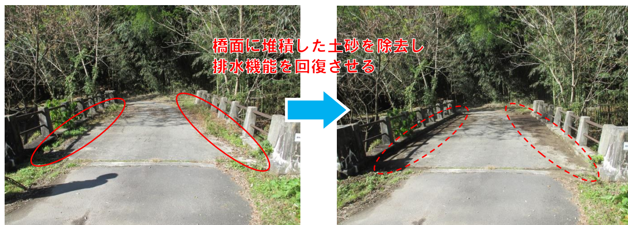
図 3.2 簡易な維持作業の例（土砂の除去）：郷土沢橋
