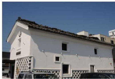
長野県中部の地震 (H23.6.30)
