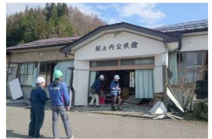
長野県神城断層地震 (H26.11.22)
