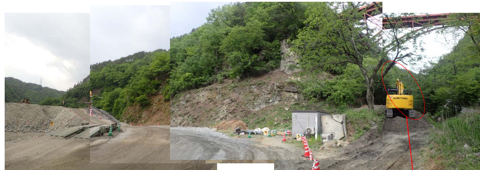
写真-046 発生土置き場の状況（2017年5月15日）。斜面には硬質な花崗岩が分布。斜面途中からの湧水は認められない。
