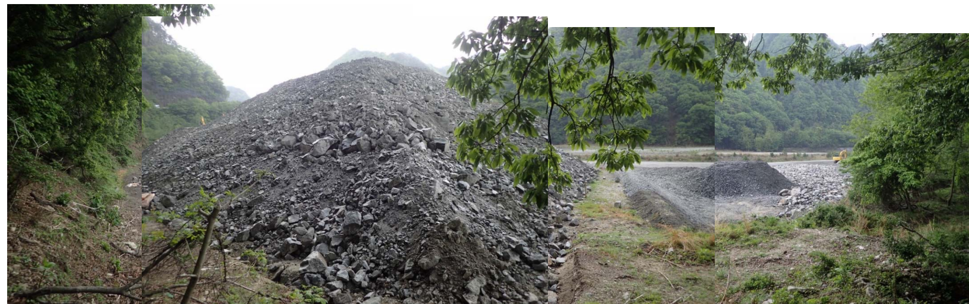
写真-050 沢の出口の状況。トンネルの掘削ズリが搬入されている。
