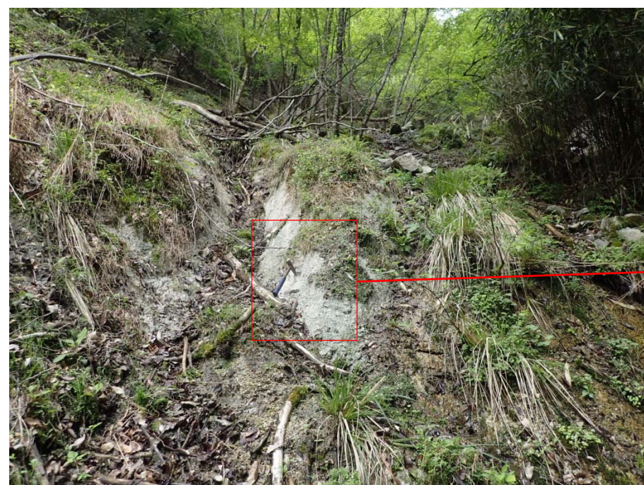
写真-010 半の沢上流部の状況。沢の右岸側（写真左手）には、粘土化した花崗岩が分布する。
