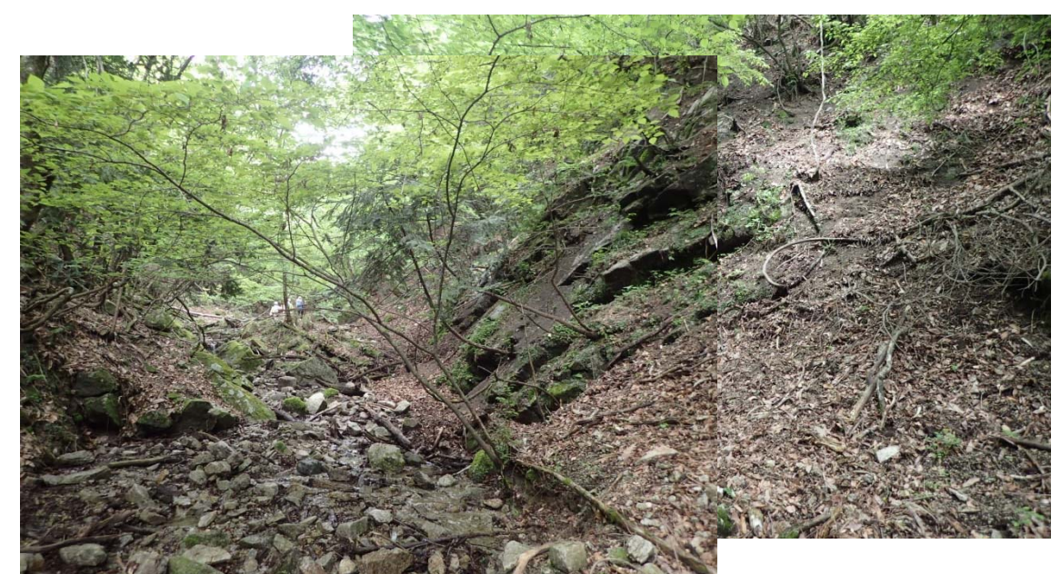
写真-039 沢の左岸側の斜面の状況。板状節理の発達する花崗岩が露出。
