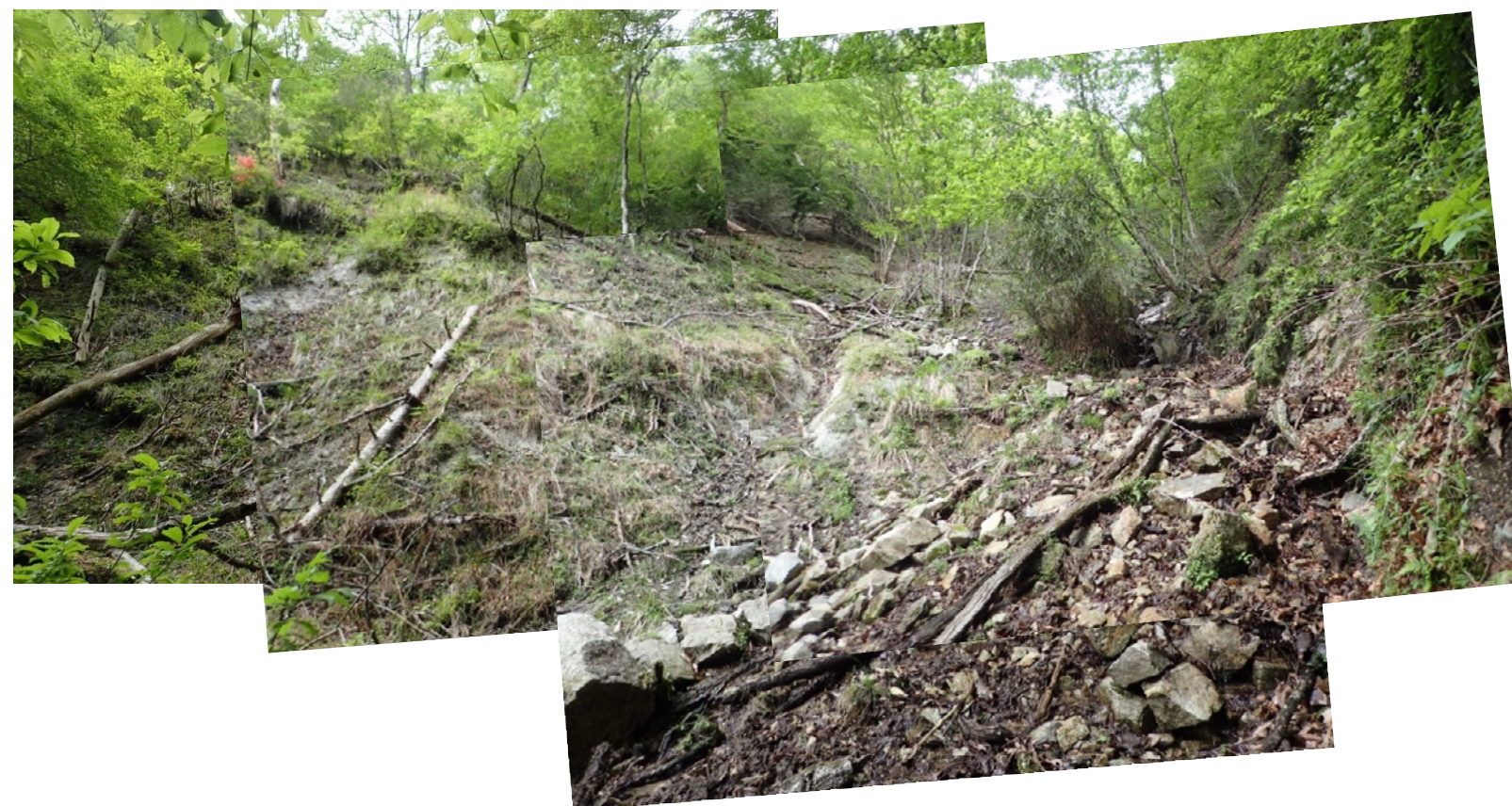
写真-014 沢を下流側から上流側方向を見上げた状況。写真の左手（沢の右岸側）には、粘土化した花崗岩が分布する。写真の右手（沢の右岸側）には、硬質な花崗岩が分布する。写真左手の斜面は、特に植生が乏しく表層崩壊跡と推定される。
