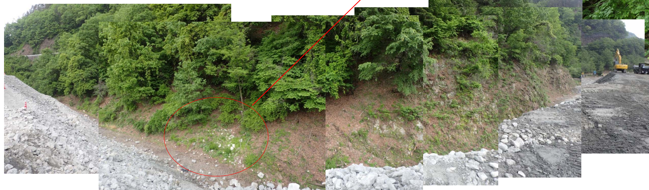
写真-048 発生土置き場の状況（2017年5月15日）。斜面には硬質な花崗岩が分布。斜面途中からの湧水は認められない。
