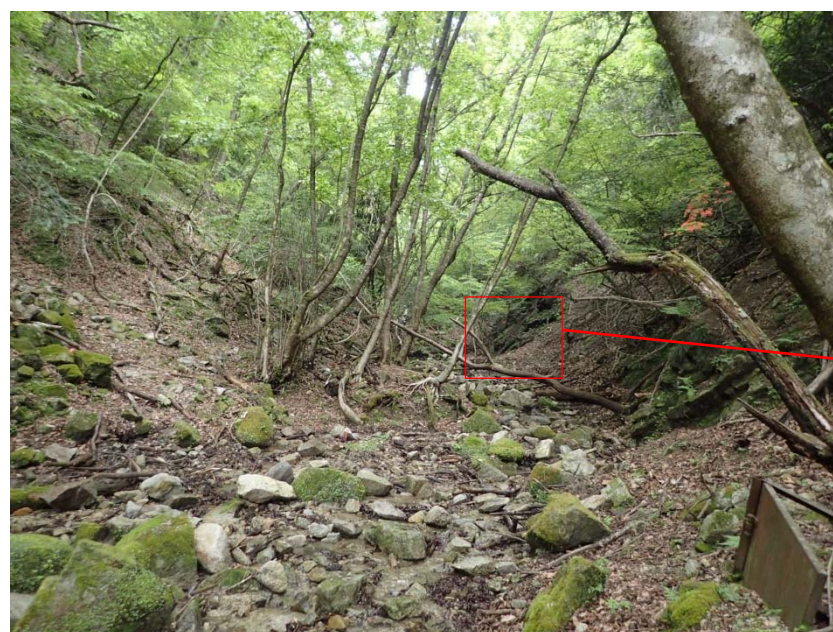
写真-037 沢の中央部の状況。
