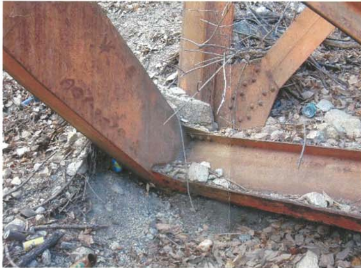
上流側 アーチアバット状況
