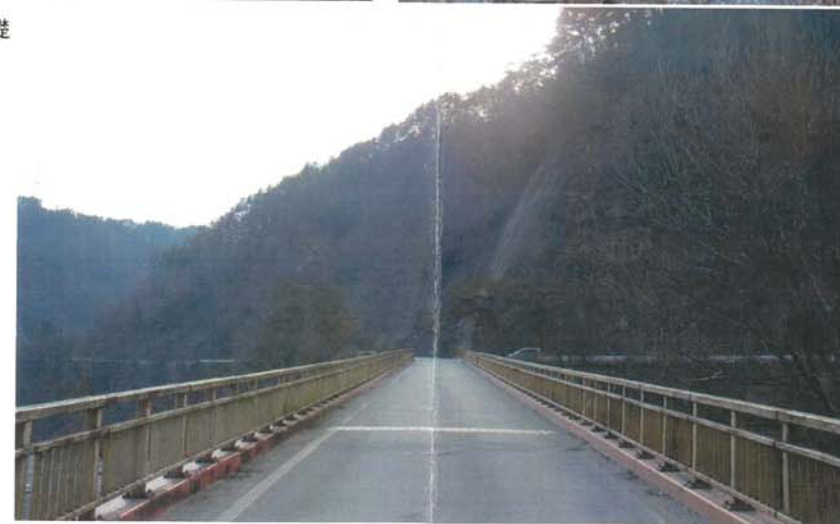
右岸側 背面状況 : 背面に山が遠いので、山腹へのケーブルクレーン基礎の設置不可
