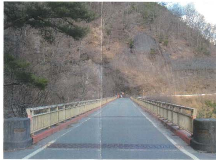
左岸側 背面状況 :山が近いので、山腹へのケーブルクレーン用基礎の設置可
