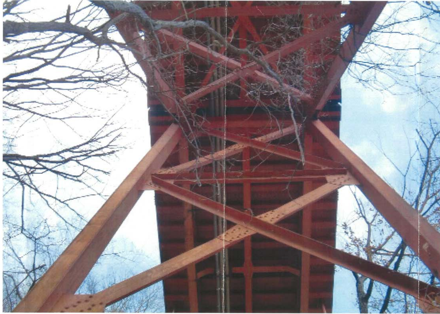
左岸側(大鹿側)アーチアバット・鉛直材現況
