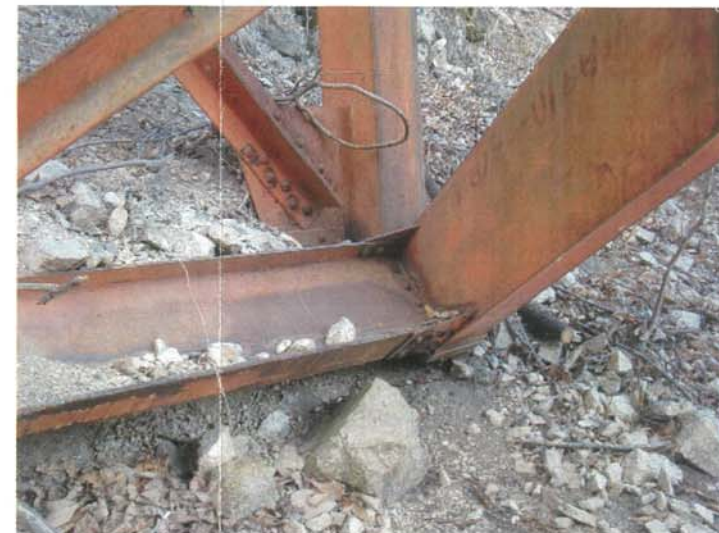
下流側 アーチアバット状況
