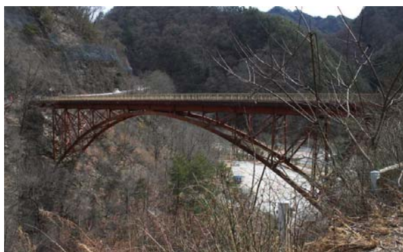
図9-3 現状の半の沢橋梁
