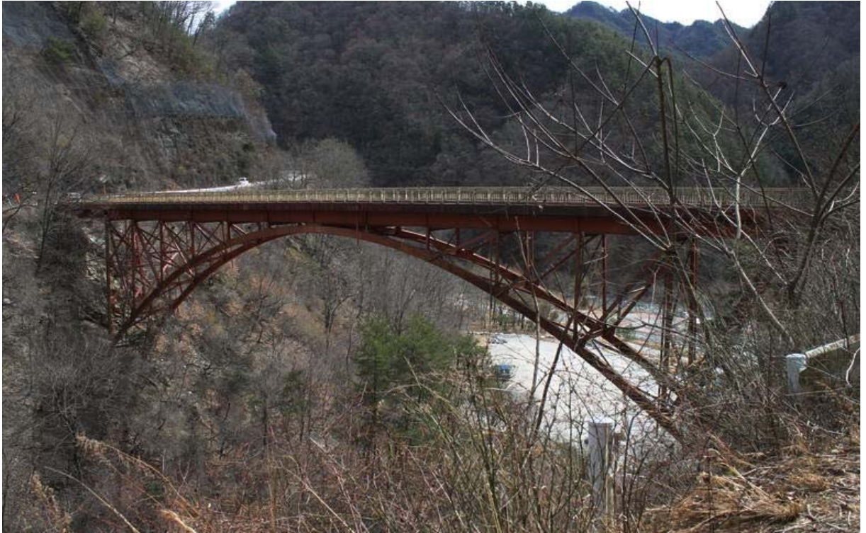
図 2 - 2 半の沢橋梁現況写真
