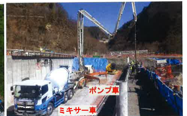
図-2 沈砂池コンクリート打設作業状況
