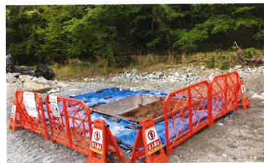
図-5 洗浄場所対策後
