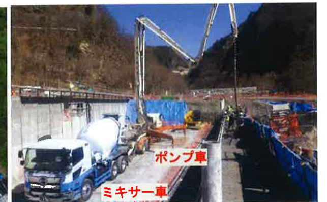
図-2 沈砂池コンクリート打設作業状況
