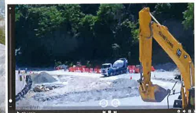
図-8 監視カメラ（録画機能付き）設置
