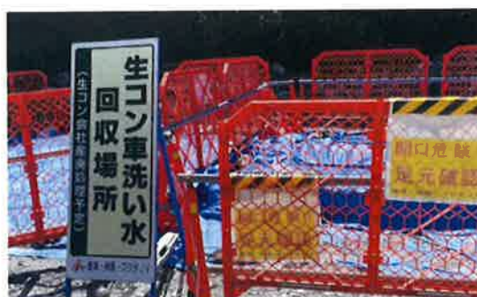
図-7 洗浄水回収場所の看板設置
