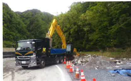
図-4 洗浄場所表土鋤取り産廃処理状況
