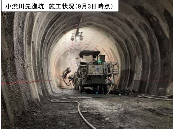
小渋川先進坑 坑内状況(9月3日時点)
