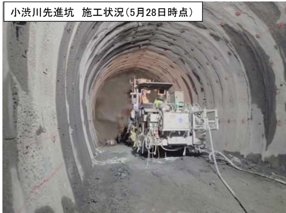
小渋川先進坑 坑内状況(5月28日時点)
