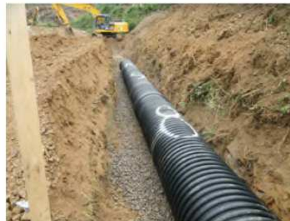
排水工(地下排水管)
