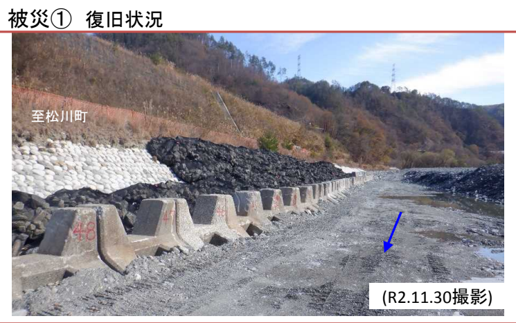
復旧状況写真
