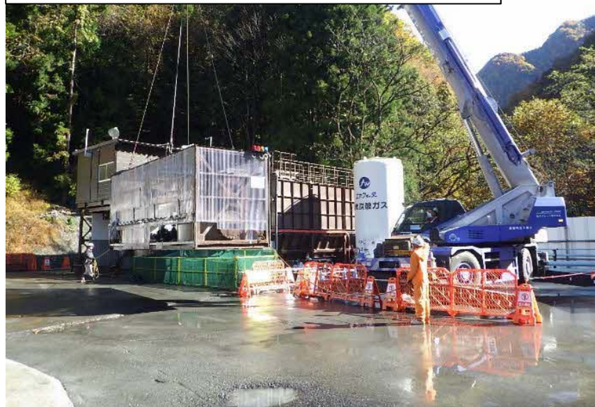
釜沢非常口ヤード 復旧工事状況(11月5日時点)
