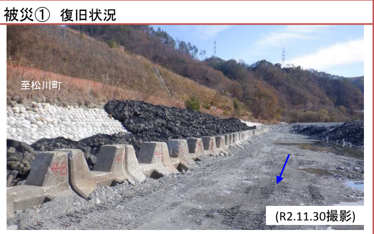
復旧状況写真
