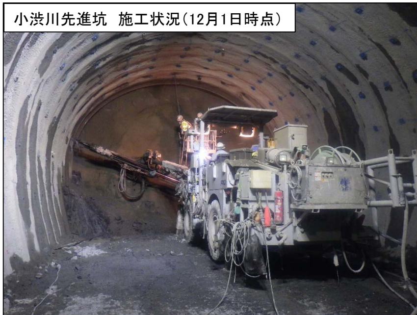
小渋川先進坑 坑内状況(12月1日時点)
