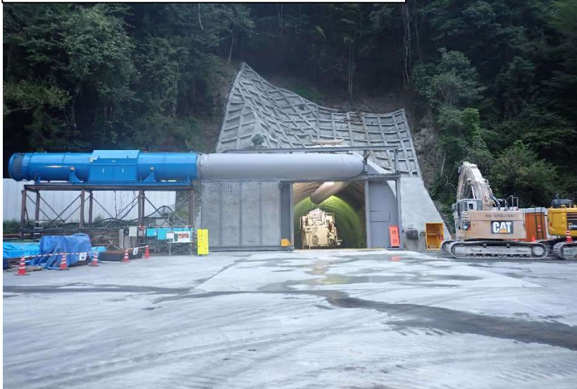
防音扉 設置状況(9月16日時点)
