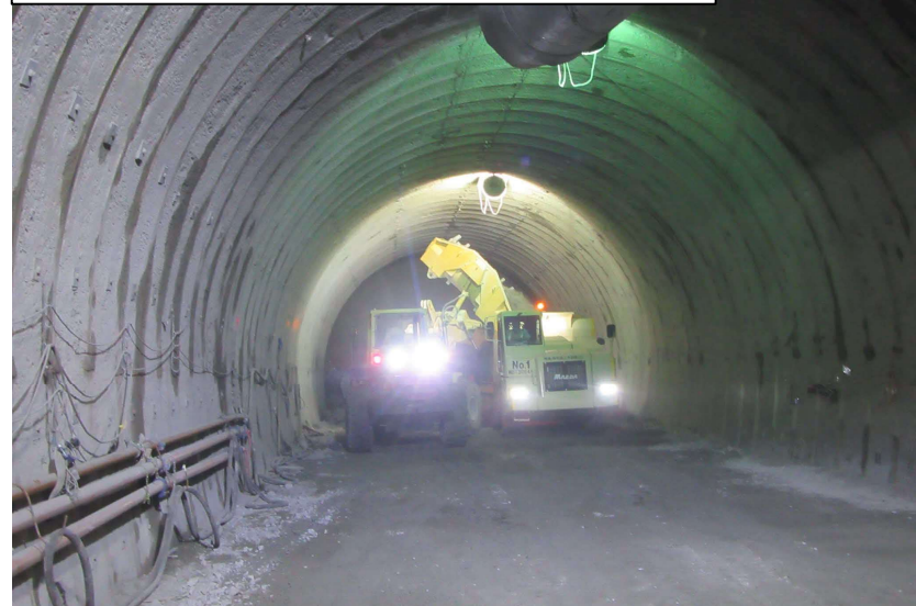
青木川斜坑 施工状況(9月18日時点)
