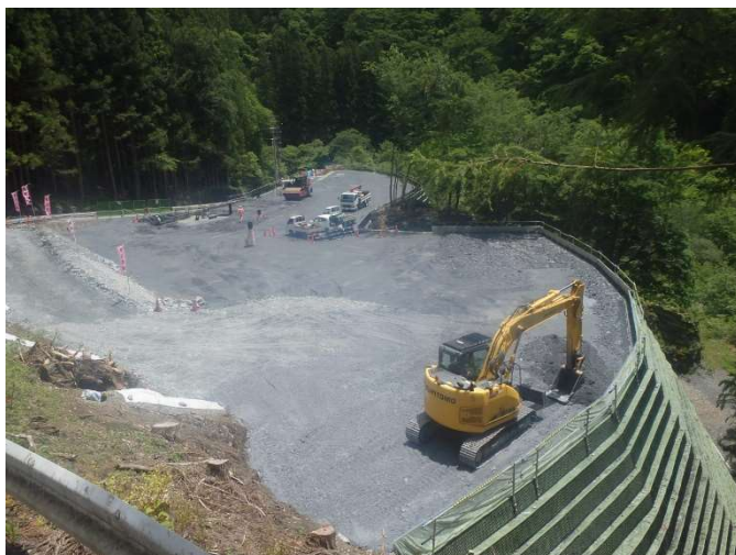
発生土置き場(旧荒川荘) 施工状況
