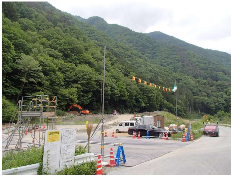
非常口ヤード
