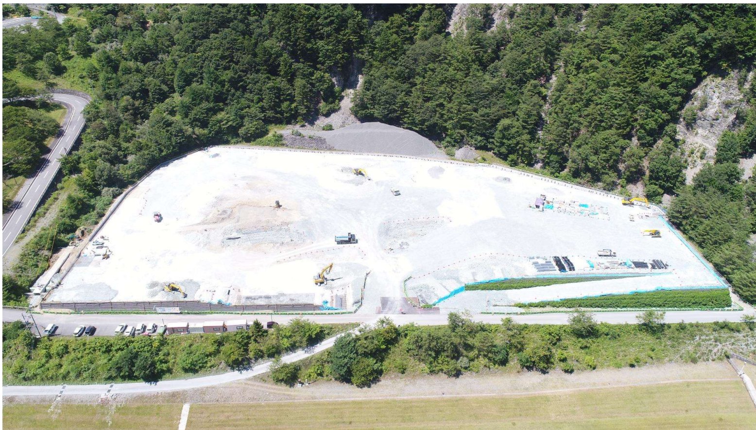
大鹿総合グラウンド整備事業 施工状況
