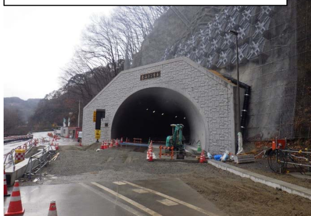
【終点側】 坑口部 すり付け版 施工状況
