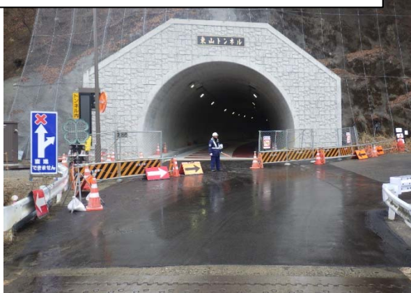
【起点側】 坑口部 すり付け版 施工状況
