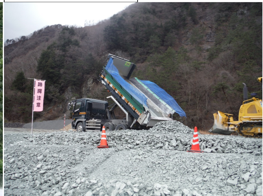
大鹿総合グラウンド(施工状況)
