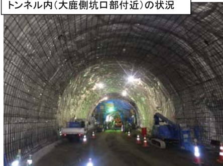
トンネル内(大鹿側坑口部付近)の状況
