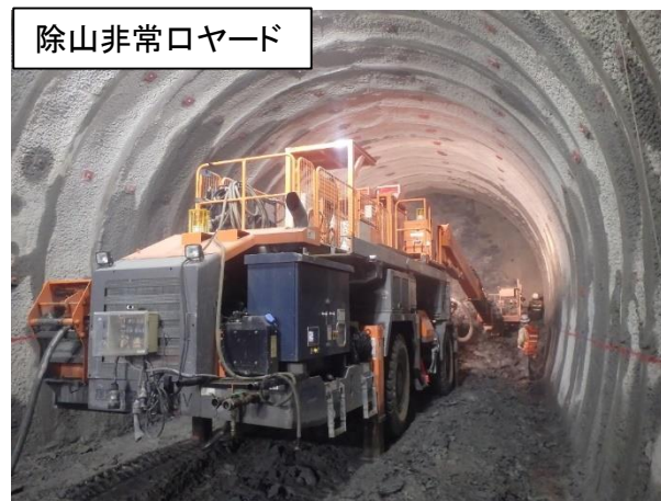
除山非常口ヤード
