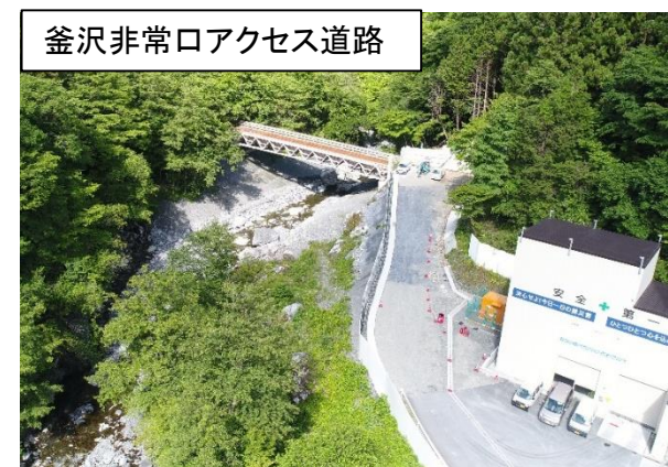
釜沢非常口アクセス道路
