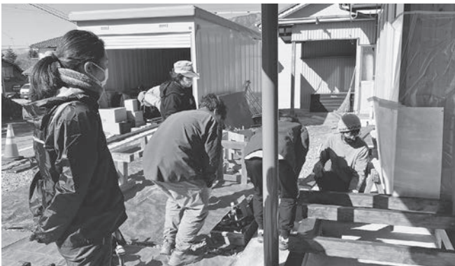
難しい作業に四苦八苦しながらも、最後は慣れた手つきで完成いただきました。
