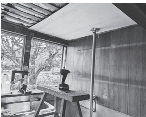
台所の天井をDIYにて改修。 半年かけて住める状態にしました。
