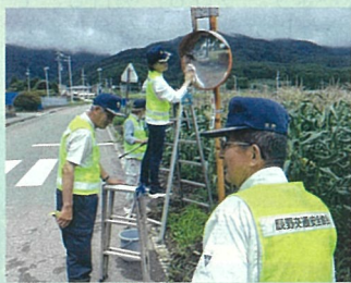
町内の小学校・保育園・幼稚園の近くに設置されたカーブミラーの点検・清掃作業を実施した。(辰野)
