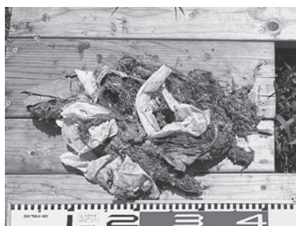
ポンプに詰まっていたごみ
