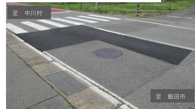
④伊那生田飯田線 舗装修繕 R7.6月に中川村にて修繕済 (④～⑥)
