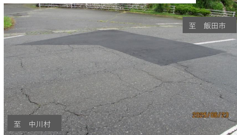
⑤伊那生田飯田線 舗装修繕 R7.6月に中川村にて修繕済 (④～⑥)
