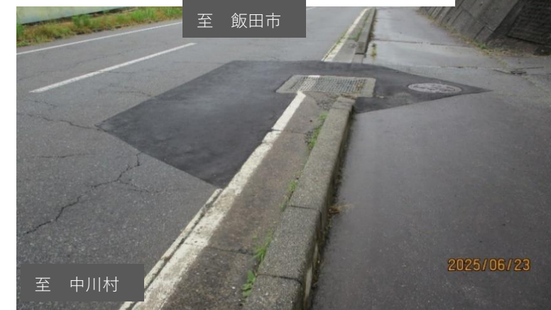
⑥伊那生田飯田線 舗装修繕 R7.6月に中川村にて修繕済 (④～⑥)
