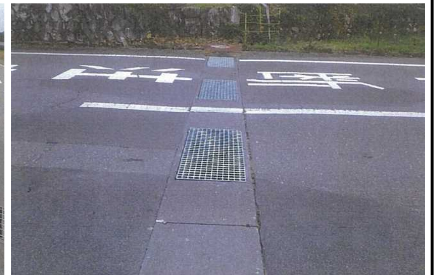
グレーチング交換完了
