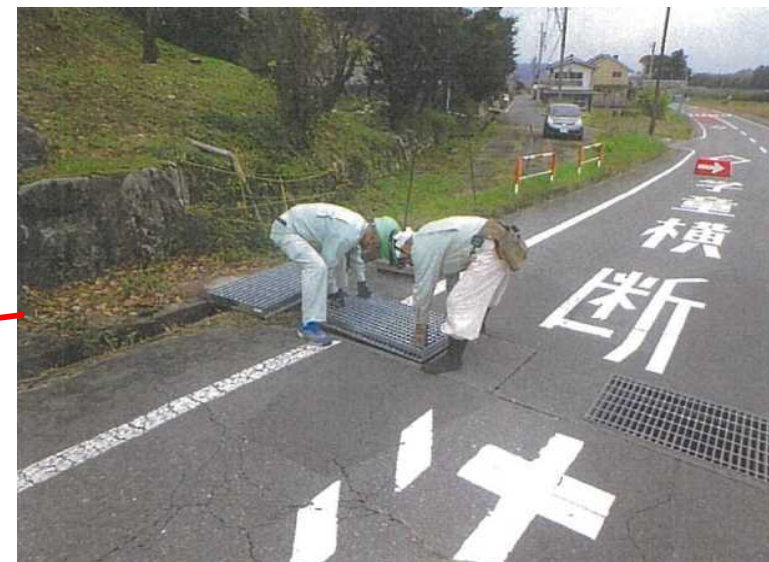
グレーチング交換状況
