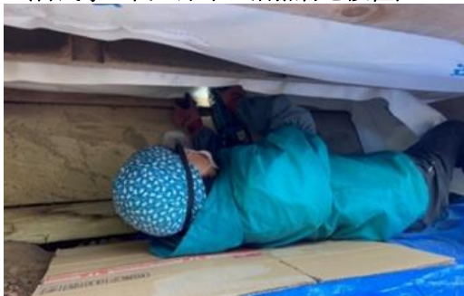
村内の断熱改修事例① (古民家七代 床下に断熱材を設置)
