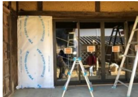
村内の断熱改修事例② (bistro vita 二重窓を設置)
