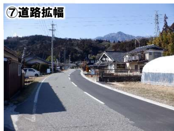
⑤歩道車道化・カラー舗装・交差点拡幅・立木伐採
