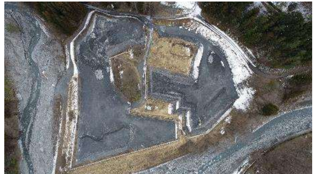
発生土仮置き場B(現在の状況) 仮置き量: 締固めで約27,000m 3
