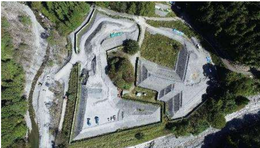
発生土仮置き場B(2021年10月の状況) 仮置き量: 締固めで約82,000m 3
