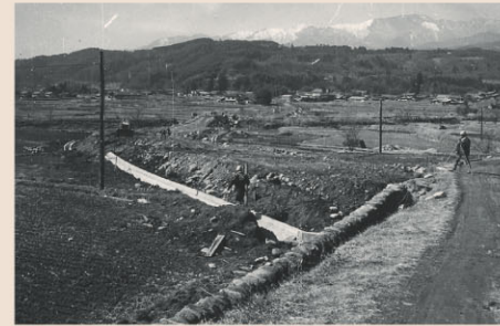
建設中の国道153号、中央地区付近(昭和42年)
