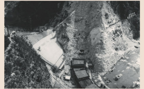
建設中の小沢ダム(昭和41年)
