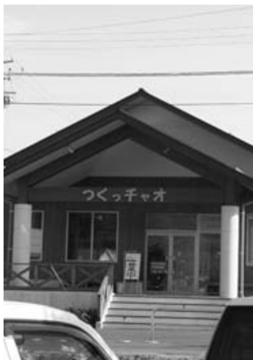
改築で設備の充実した農産物加工施設
